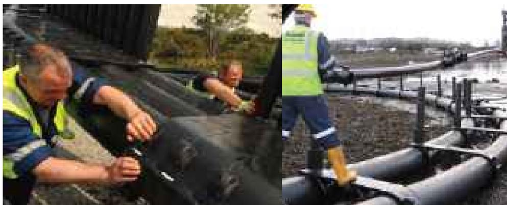
**Figure 5.13 – Deux étapes de fabrication d'une cage en PE (Photos : Fusion Marine)**
